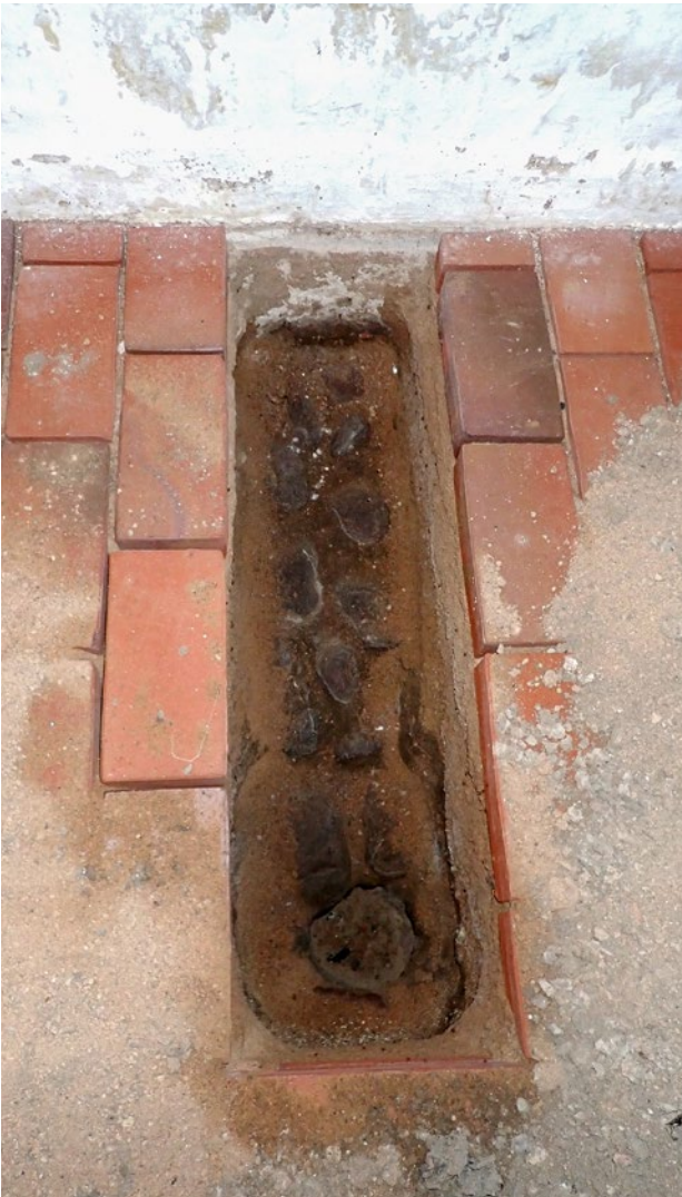
Figur 21: Foto av en befintlig provgrop i slottets källares sydöstra del. Foto: Sofie Renström. (Fotonummer 2022-92-13).
