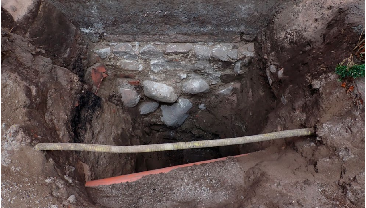
Figur 13: Schakt 2000 efter att det grävts till 2,8 meters djup. Botten av murgrunden kunde inte bekräftas ännu på denna nivå. Närmast i bilden syns moderna ledningar som skar kulturlagren i söder. Foto: Sofie Renström. (Fotonummer 2022-92-27).
