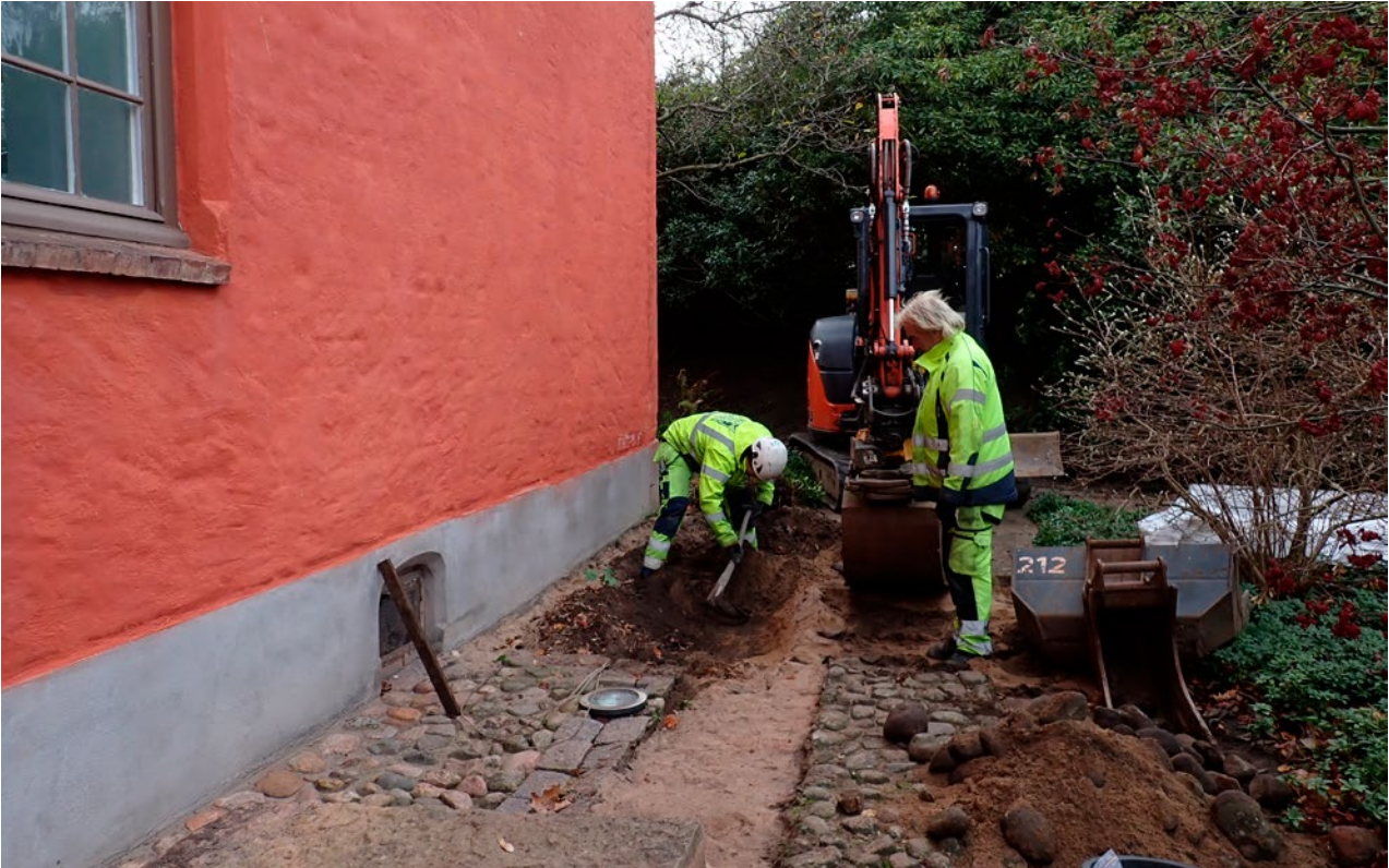
Figur 17: Schakt 3000 intill den västra slottsväggen öppnas. Foto: Sofie Renström. (Fotonummer 2022-92-30).
